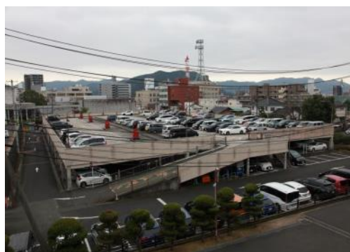
老朽化した中央駐車場
