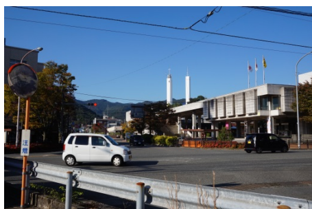
中国電力向かい側付近
