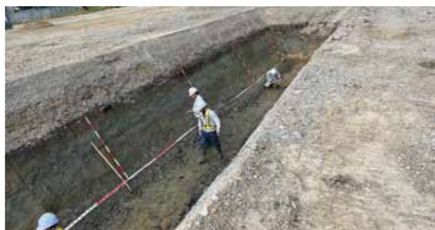
トレンチ調査（実地調査）の様子
