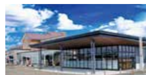
道の駅「きらら あじす」
